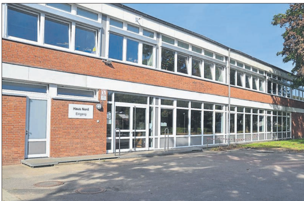
Das Nordgebäude der Albersdorfer Gemeinschaftsschule soll neue Technikräume bekommen. Foto: Thode
